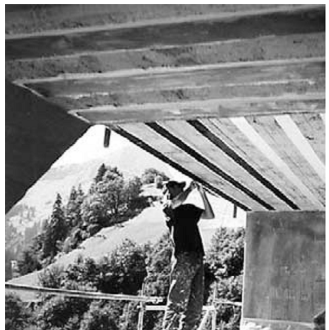
Att. 4. Tilta pastiprināšana, izmantojot kompozīta loksnes
